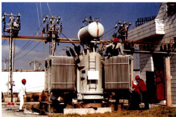
茨坝变电站变压器防腐处理
