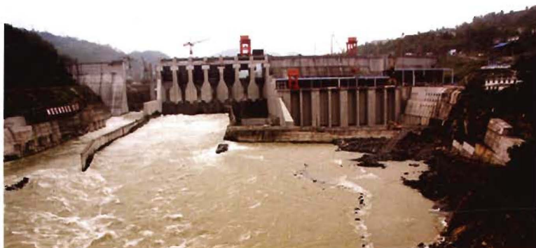
沙陀电站(装机4 X280兆瓦),2013 年一季度首台机 组投入运行
