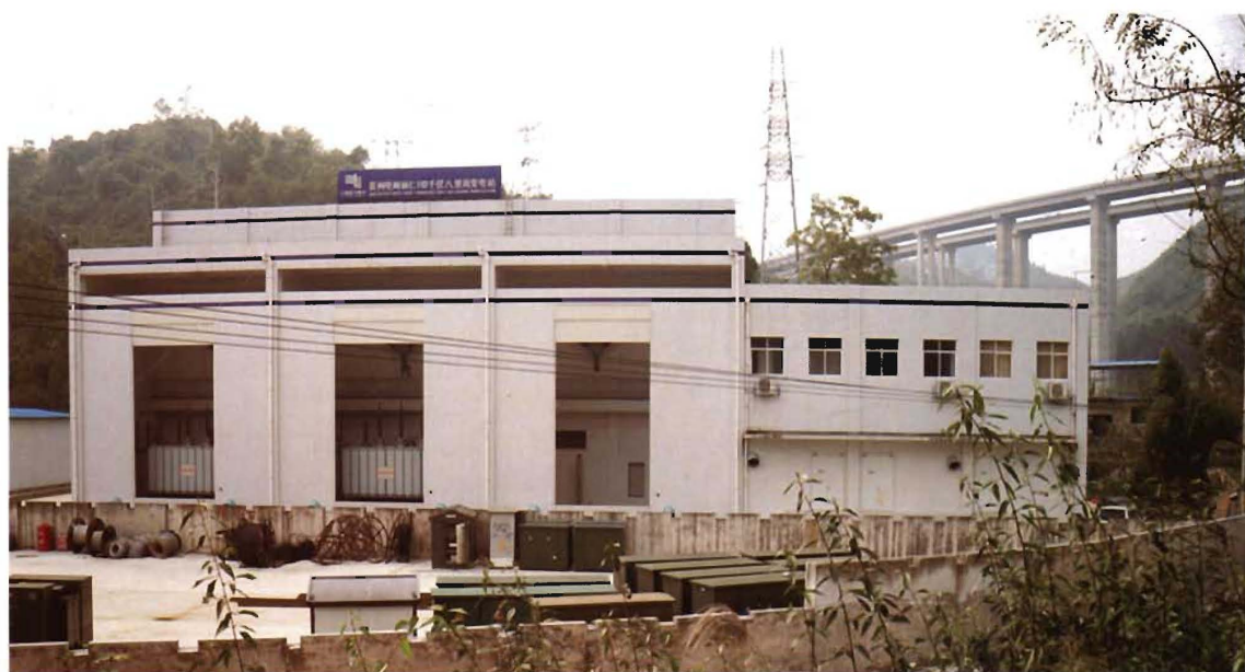
110千伏八里岗变电站(主变终期容量3X50兆伏安),2009年 12月31日投入运行是铜仁第一座GIS变电站
