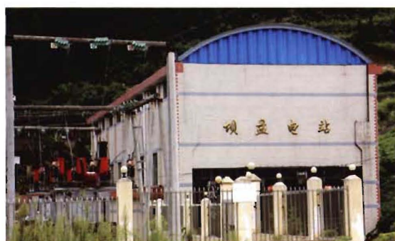
坝盘电站(装机2X3.2+6.3兆瓦), 2008年1月首台机组投入运行
