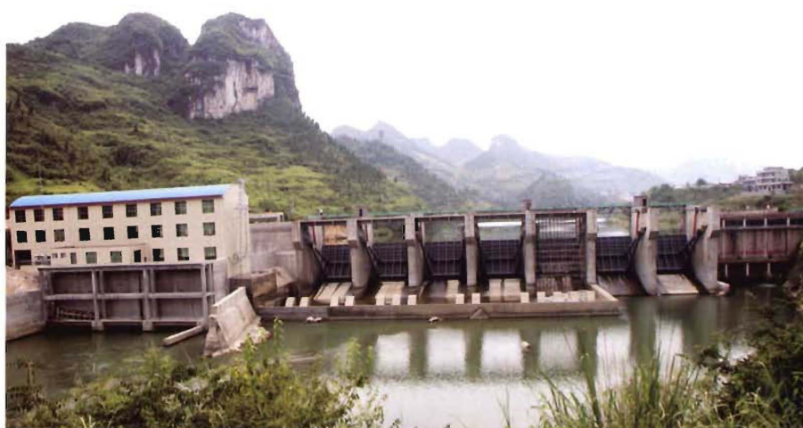
芦家洞电站 (装机3X7兆瓦), 2012年5月 12日1号机组 发电并网
