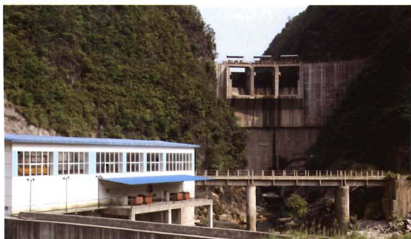
马槽河电站(装机2X4.9兆瓦), 2008年4月16日 建成投运
