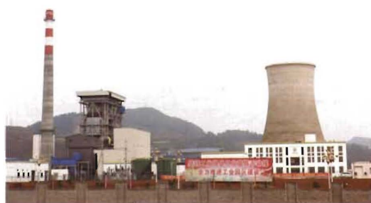
松桃凯迪生物质发电厂(装机 30兆瓦), 2013年建成投运
