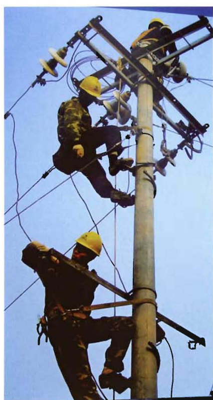
35 千伏线路检修
