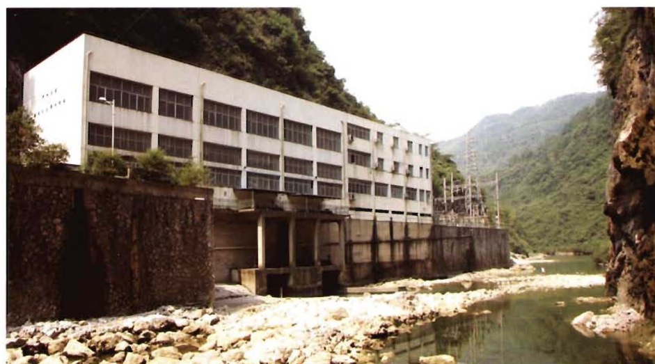
天生桥电站 (装机2X11兆瓦), 2007年6月 19日建成投运
