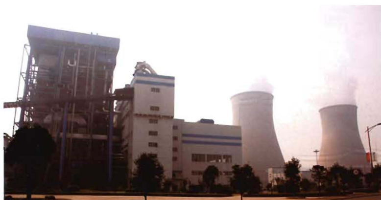
大龙火电厂(装机2 X300兆瓦),2006 年3月建成投运
