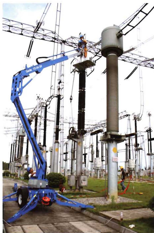
220 千伏设备检修
