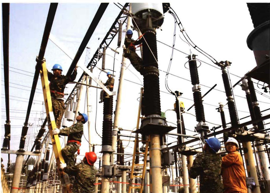
500 千伏设备检修
