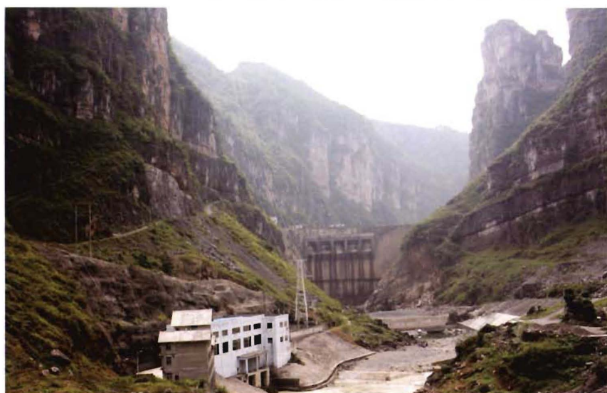
白水泉电站(装机2X10兆瓦), 2007 年5月建成投运
