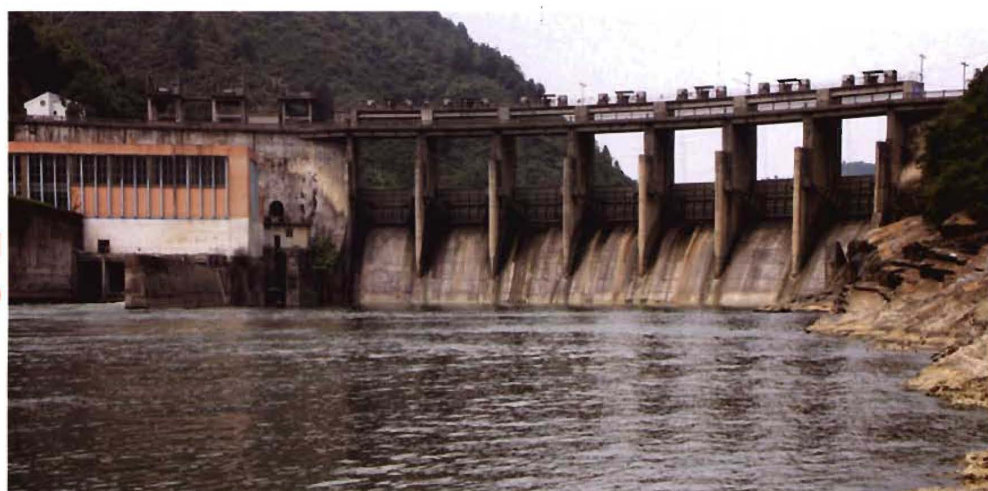
溪头电站 (装机2X8 兆瓦),1991 年7月建成 投运
