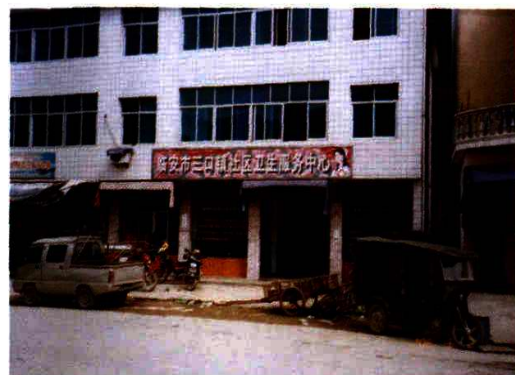
临安市三口镇卫生服务中心（卫生院）
