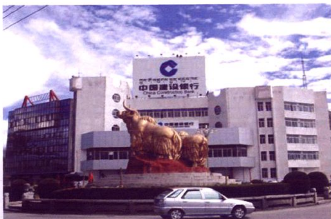
现区分行办公大楼
