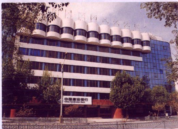
现区分行办公大楼
