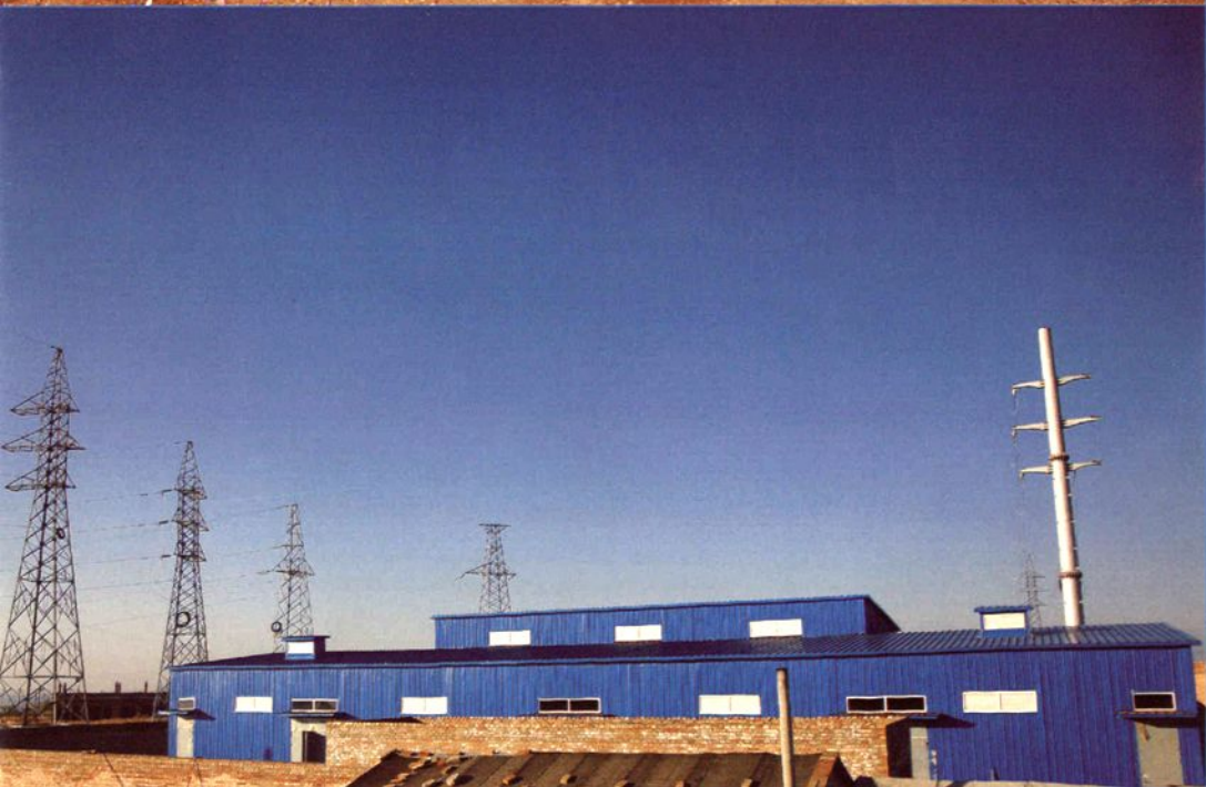
正在建设中的刘家山110千伏变电站
