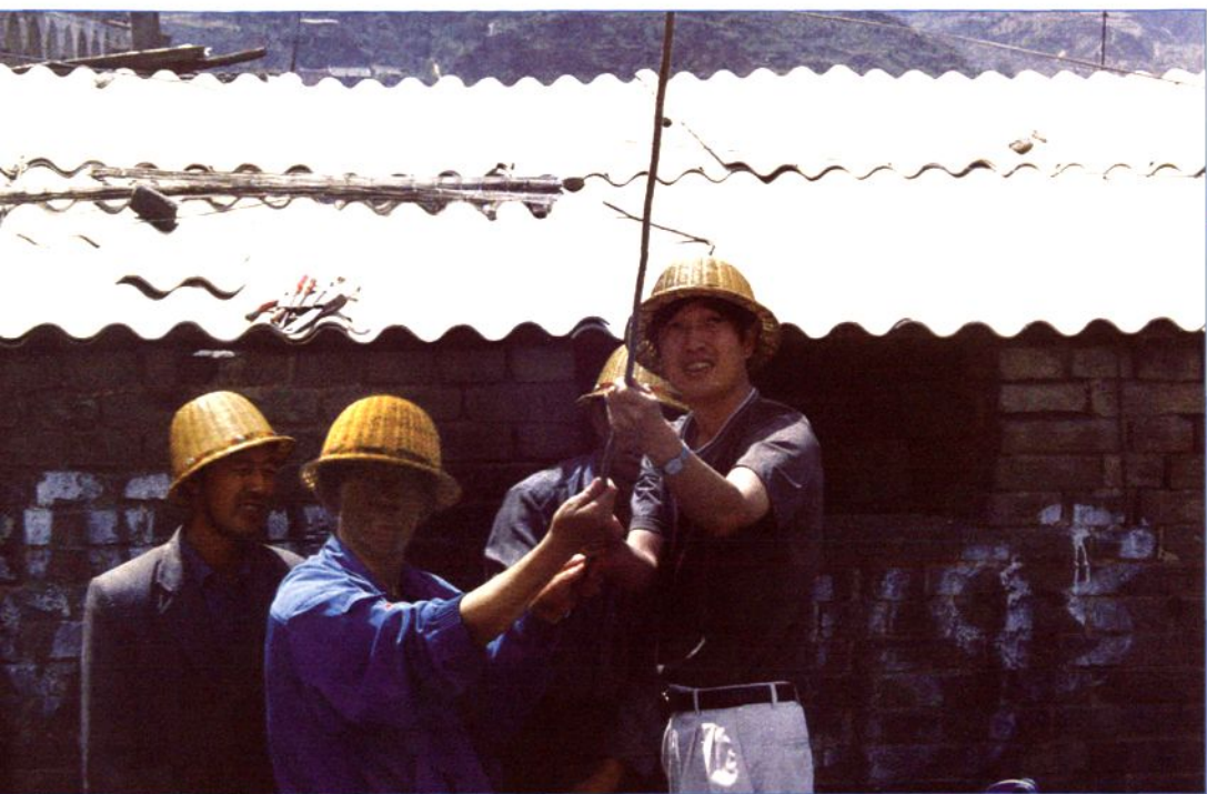
原副经理李贵平（右）在城网改造工程现场
