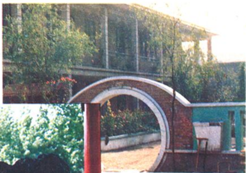
建设局办公楼▷
