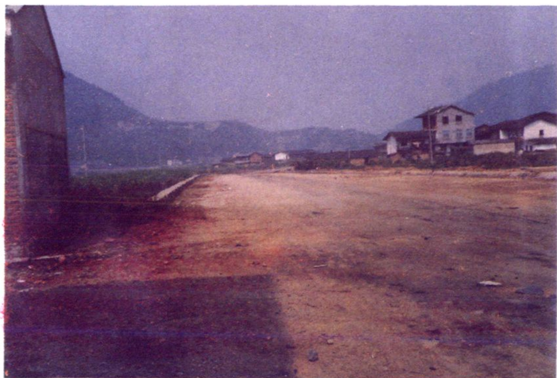
改线后的省道后茅线永安西洋路段路基
