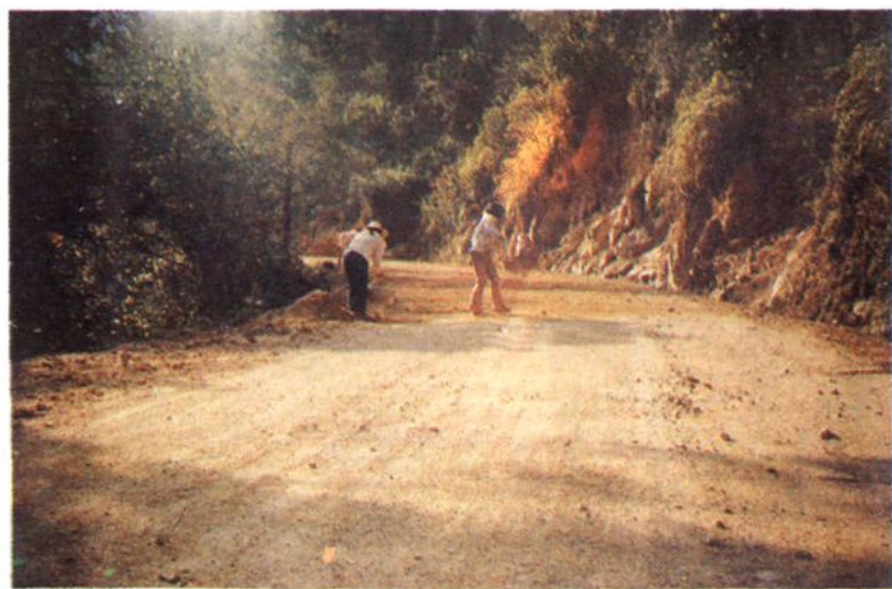
养路工人在县乡公路上养路
