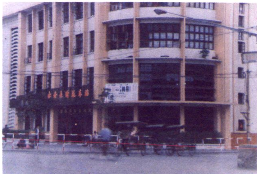
永安市汽车客运站
