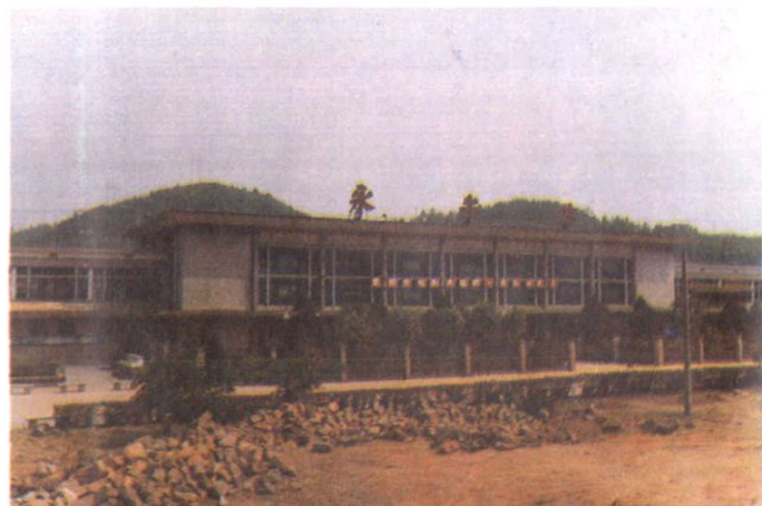
鹰厦铁路永安火车站
