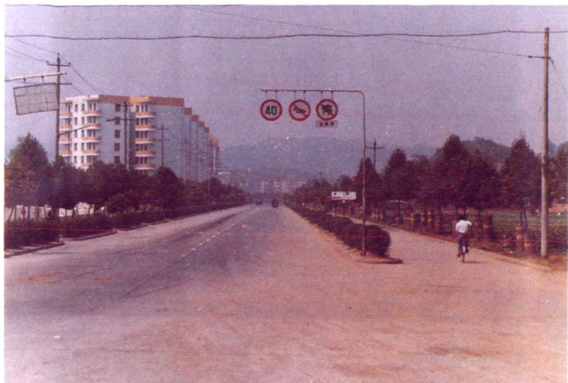
拓寬改造后的国道 205 线永安路段南大路
