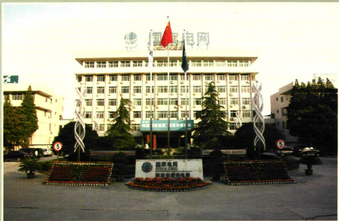
安康供电局机关大楼（2009年）
