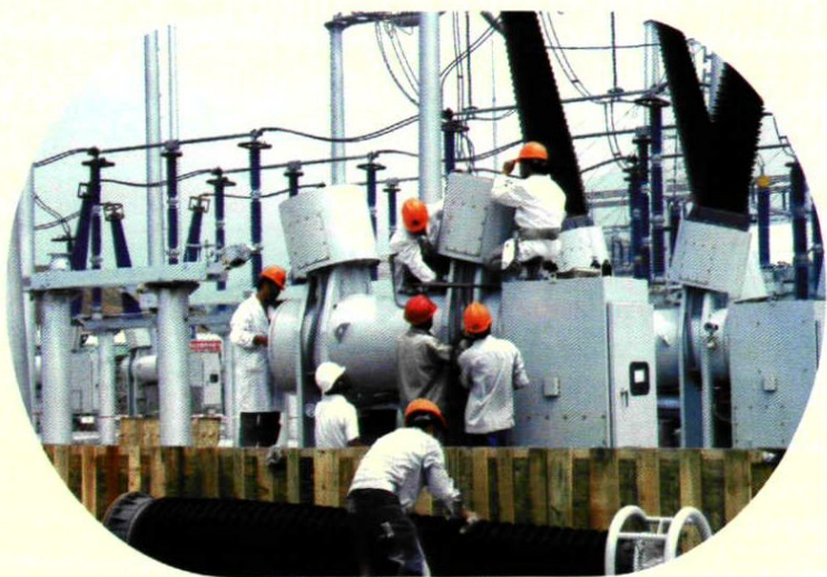
▲ 330千伏金州变二期建设施工现场
