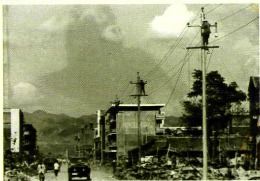
▲ 1983年8月，安康城区水灾后安康供电局职工在恢复供电
