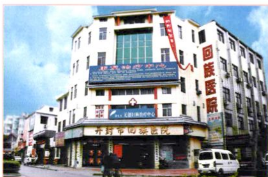
开封市回族医院大楼
