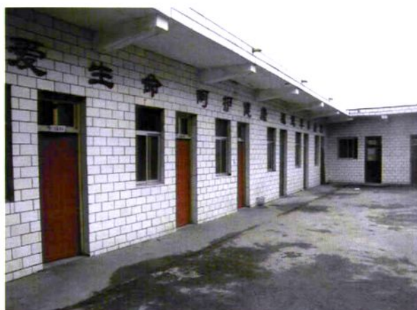
金明区杏花营农场卫生院住院部
