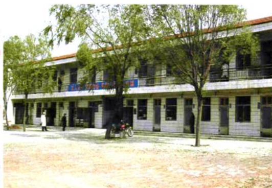
金明区水稻乡卫生院门诊楼
