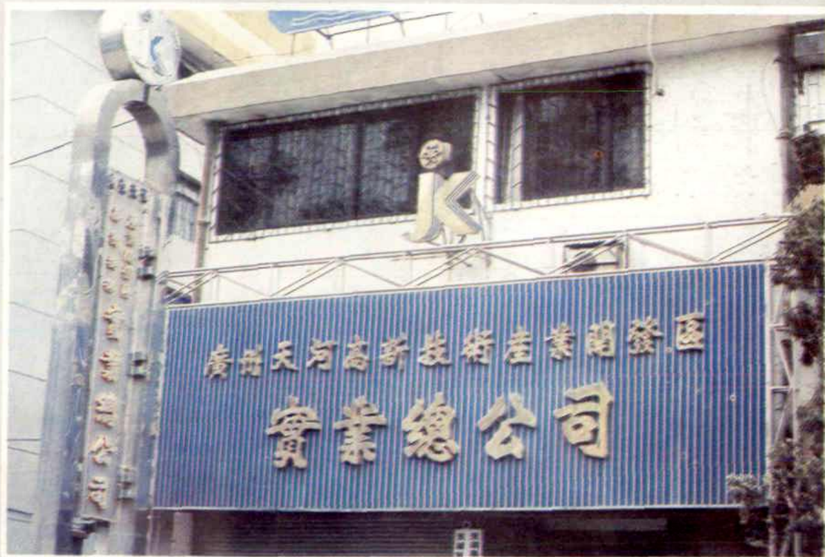
▼ 广州天河高新技术产业开发区实业总公司
