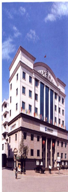
建设银行大楼
