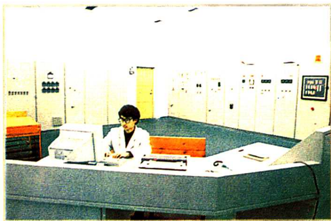
FDY生产车间中心控制室
