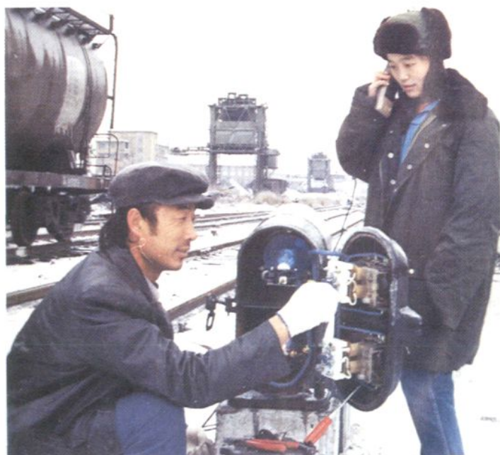
电务工人检修信号灯。
