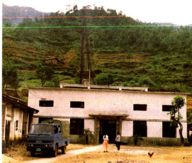
▲ 首宗县办水电站—— 白水标二级站机房外景
