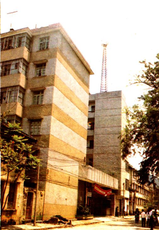
▲ 水电局大楼一角
