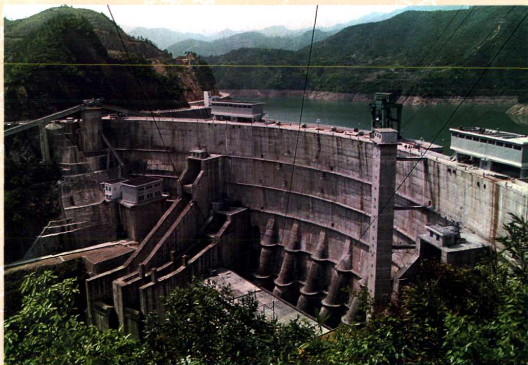
紧水滩电站大坝
