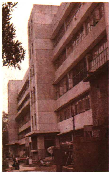
技术改造施工中的制粉车间
