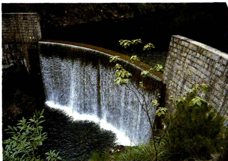
齐溪林场电站拱坝
