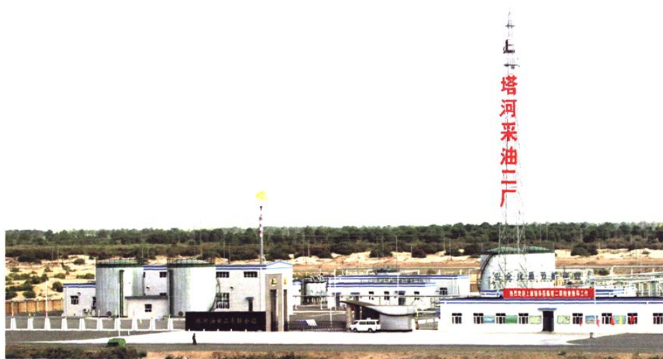
中国石化塔河油田采油二厂二号联合站 (西北石油年鉴资料库, 2005 年)
