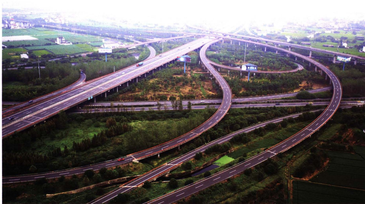
杭浦高速海盐枢纽（谢兆林摄）
