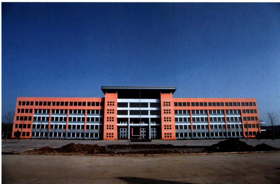
新建华亭县职教中心主教学楼（2015 年） 摄影 王永春
