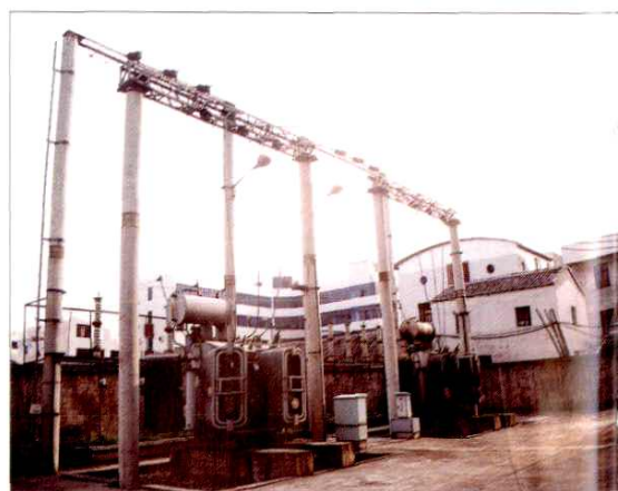
柳市变电所变压工程
