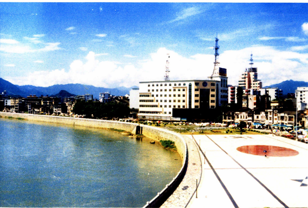
▲ 一河两岸防洪河堤
