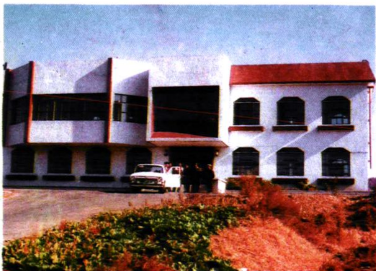
大峪发射台翻建工程于1990年12月5日投入使用
