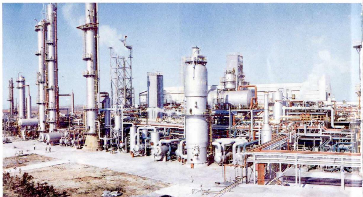
镇海石化总厂年产三十万吨合成氨和五十二万吨尿素工程
