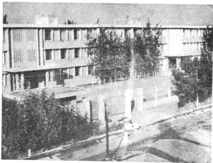
浮山县政府机关大楼
