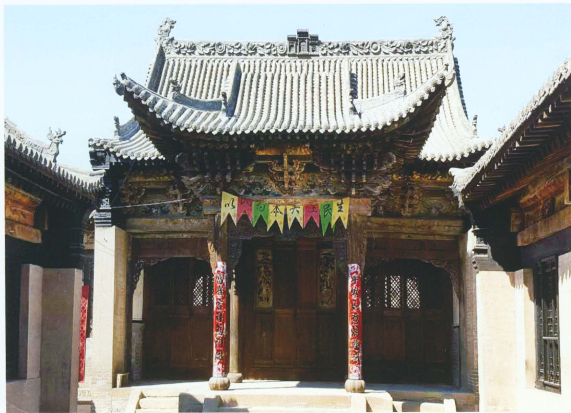
关帝庙正殿（维修后）
