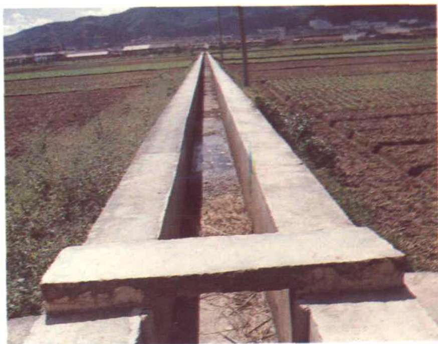
已建成的排水大沟
