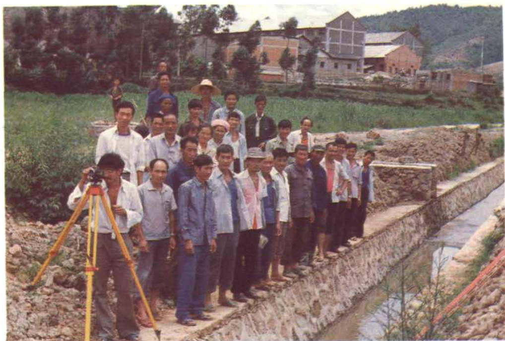
测建中的排涝大沟
