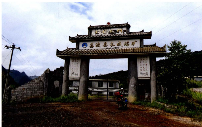
位于佳荣镇拉滩 村的荔波县长城煤矿
