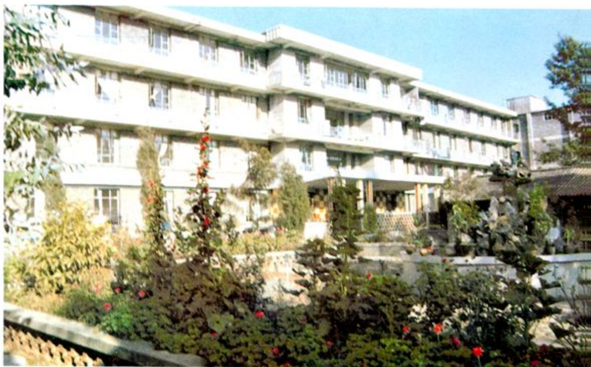
县医院住院部大楼
