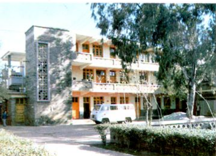
县防疫站办公楼
