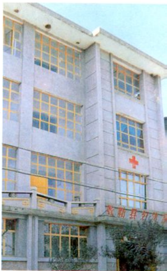
县妇幼保健站
