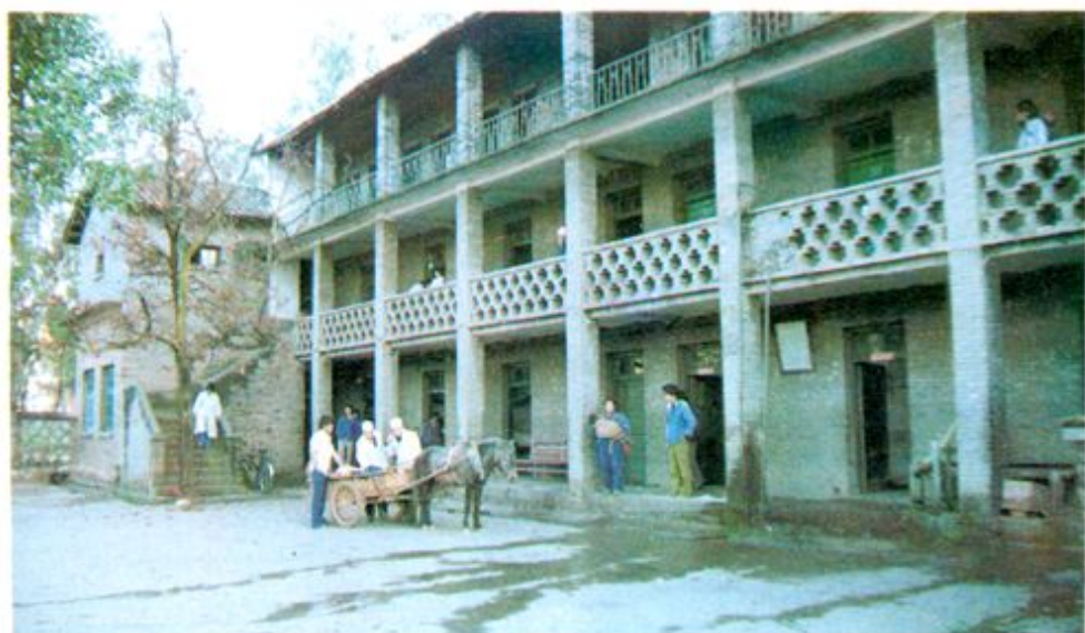
竹园中心卫生院住院部
