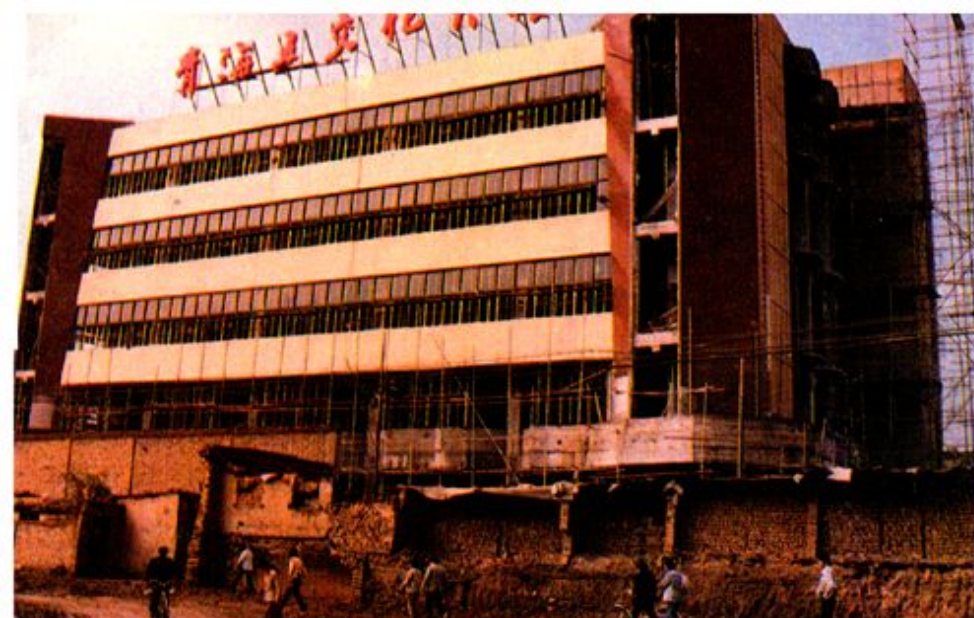
正在兴建的青海 五交化大楼（六 层6300平方米）
