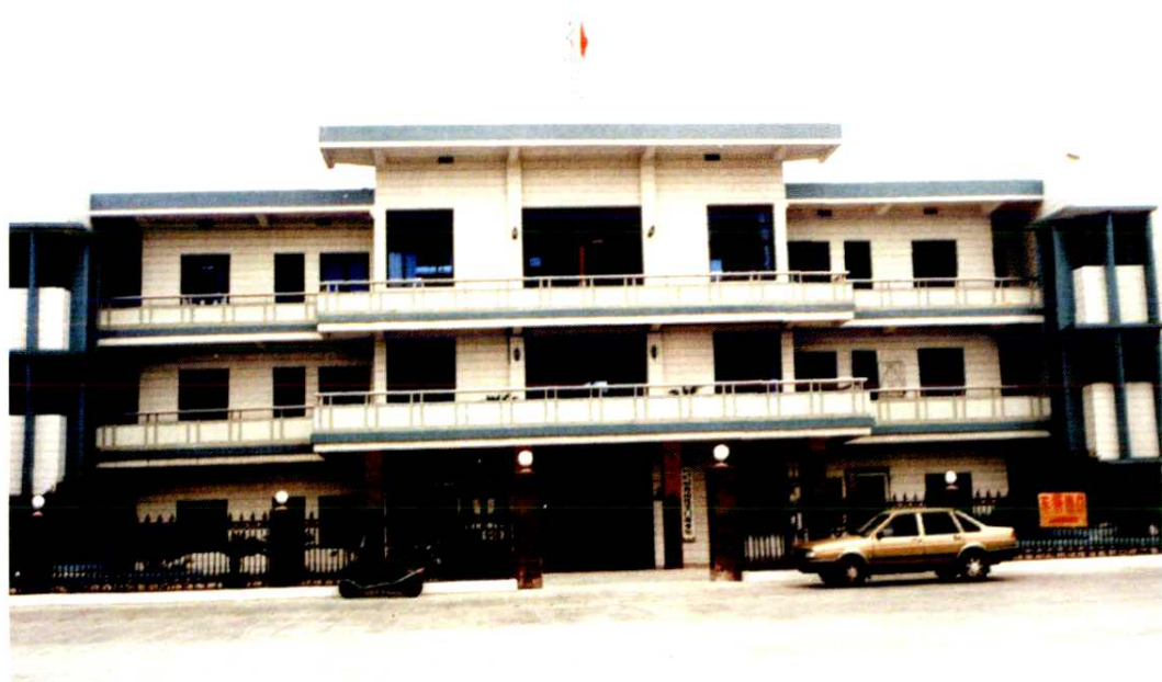
普陀区航管所办公楼
