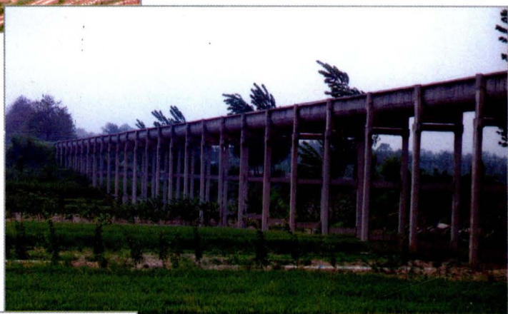
石羊抽水站万兴渡槽
