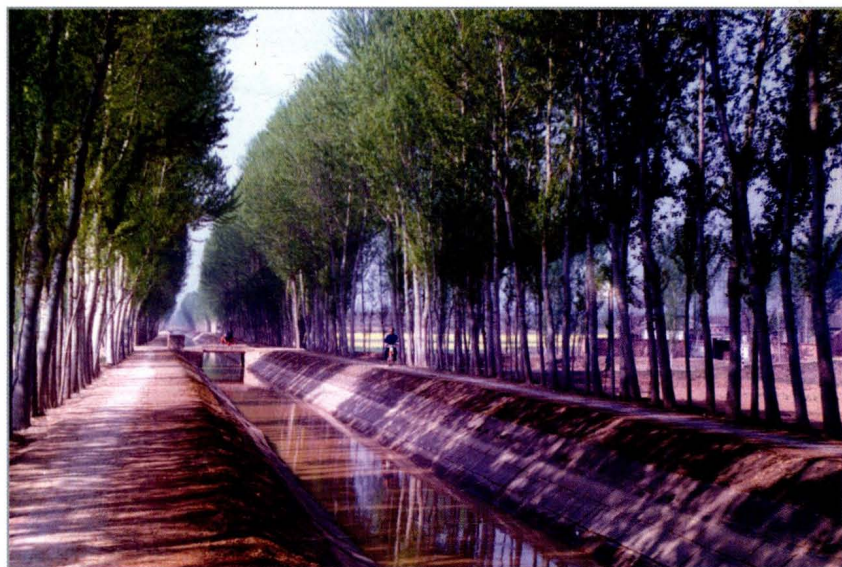
龙阳抽水站干渠
