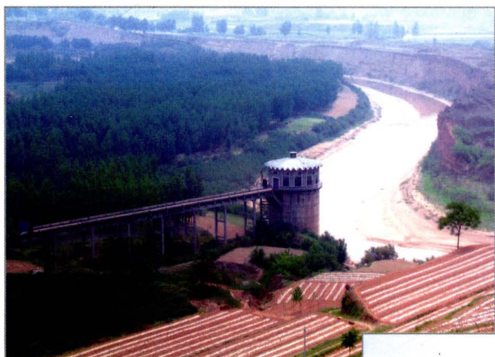
石羊抽水站一级竖井站
