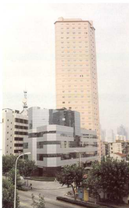
研究院科研大楼全景
