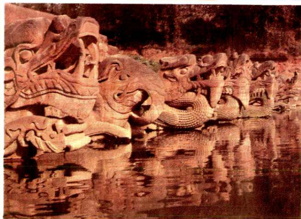
九曲河上龙脑桥 ——建于明代洪武年间
