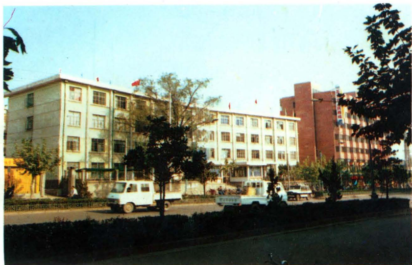
一九八二年竣工啓用的辦公樓
