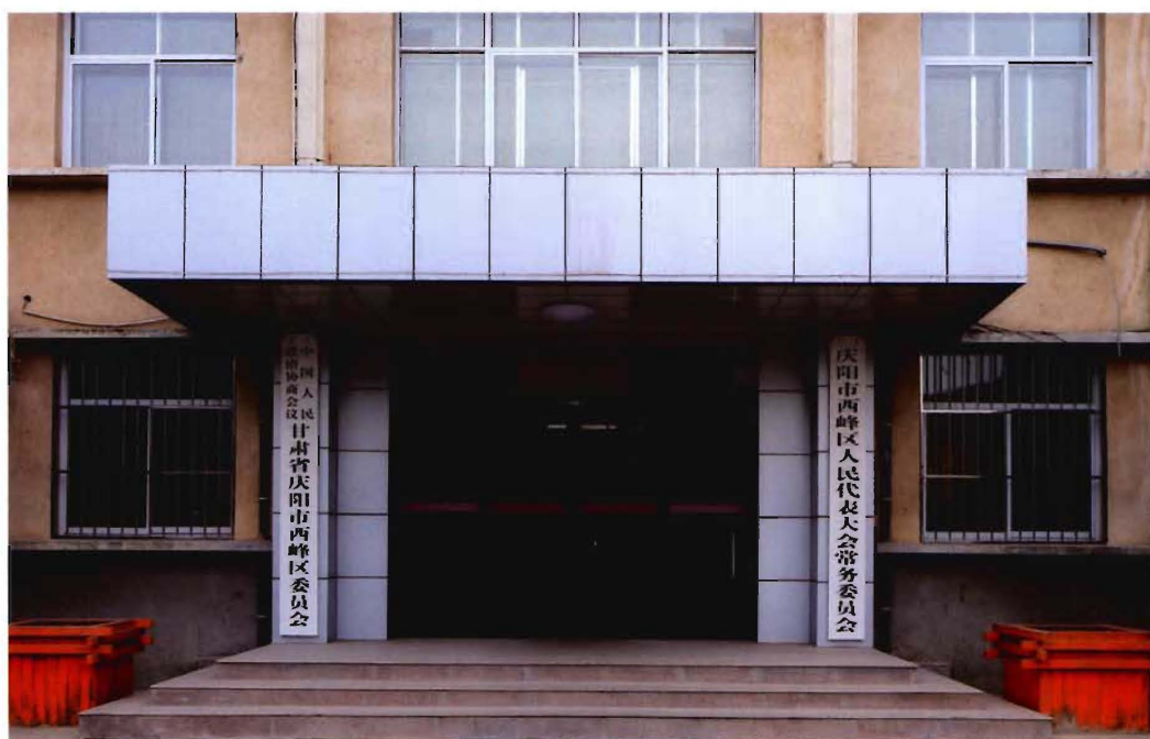
西峰区人大常委会机关办公楼（2015年）
