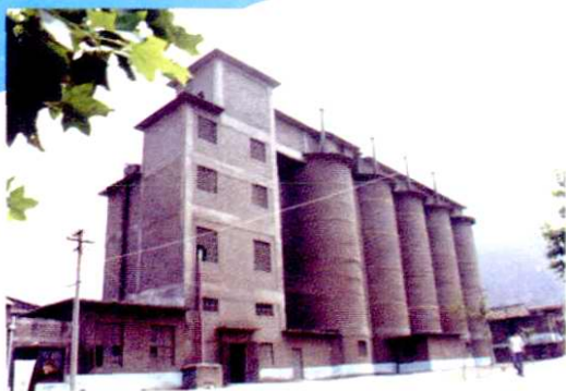
永济厂区水泥圆库
