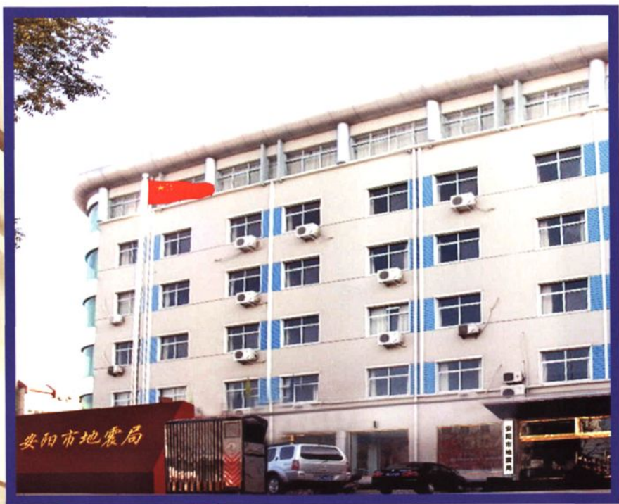
▲安阳市防震减灾指挥中心大楼
