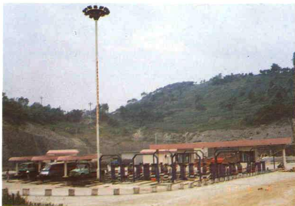
我院第一个设计施工总承包的成渝高速公路宋家沟洗车场通过验收并被评为“优良”工程
