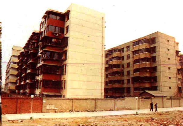
新建的玉林生活区两幢宿舍外景
