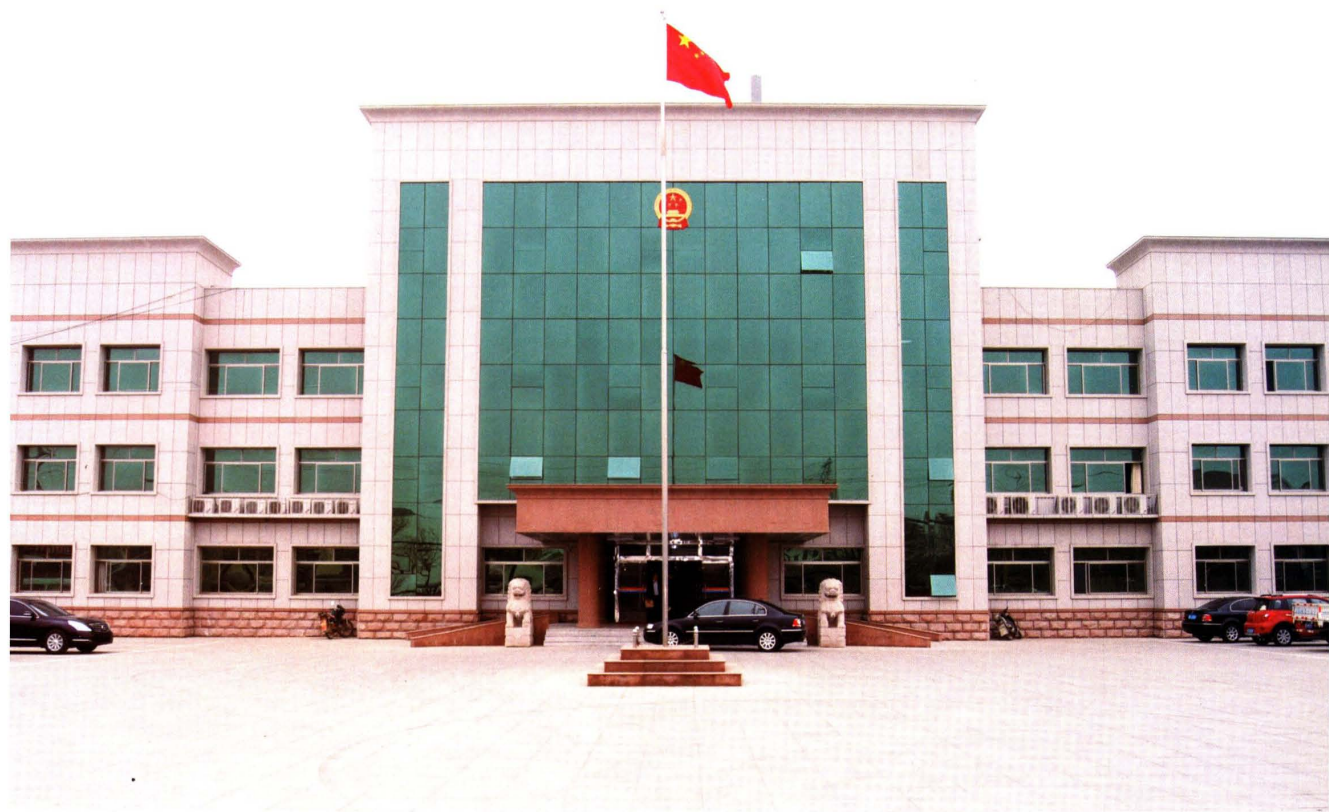
孤島鎮人民政府辦公大樓
