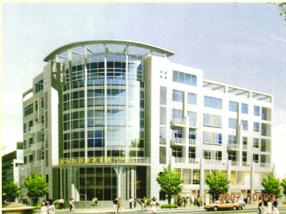
新修建的农业技术推广中心综合楼
