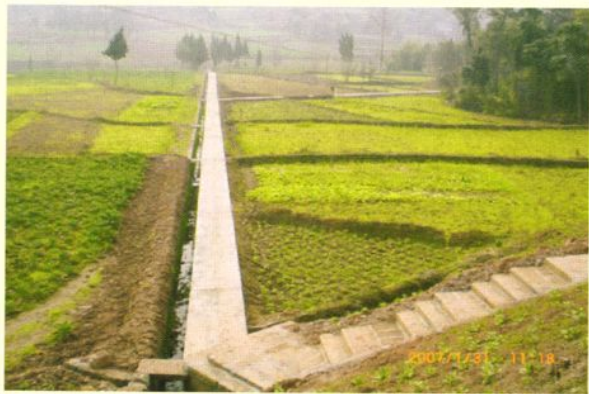
农综项目田间工程路渠建设
