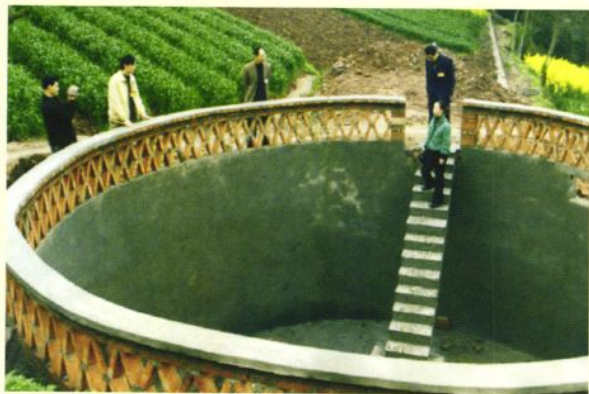
农综项目蓄水池
