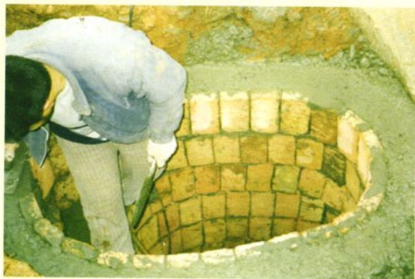
正在建设中的沼气池
