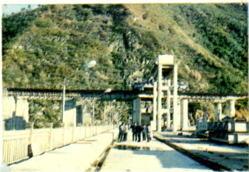
黄龙滩水库大坝升船机
