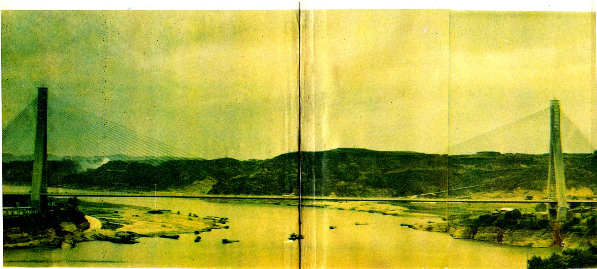
郟阳汉江大桥下的繁忙运输情景
