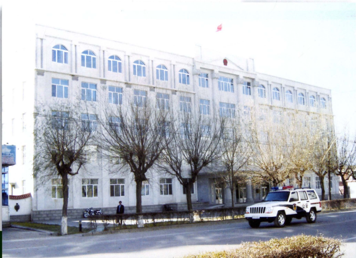
区机关办公楼
