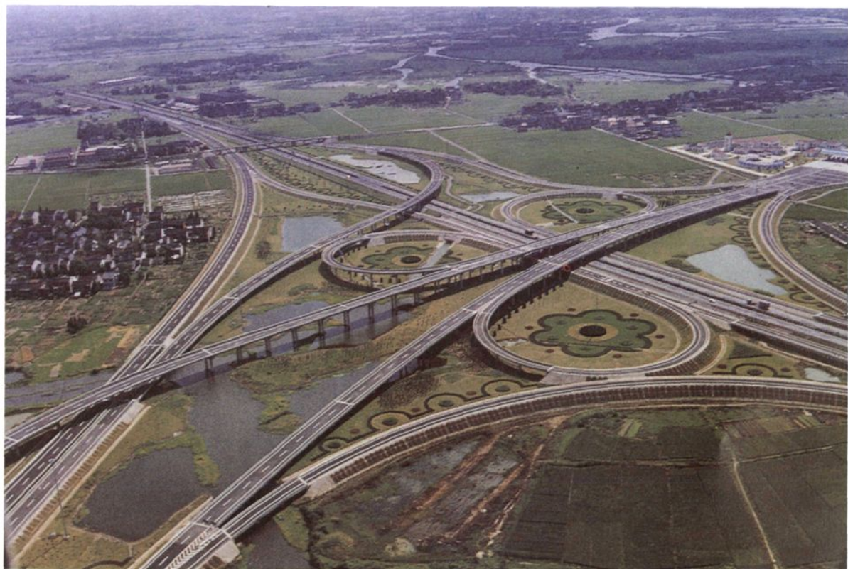
沪宁高速公路、锡澄高速公路东北塘互通
