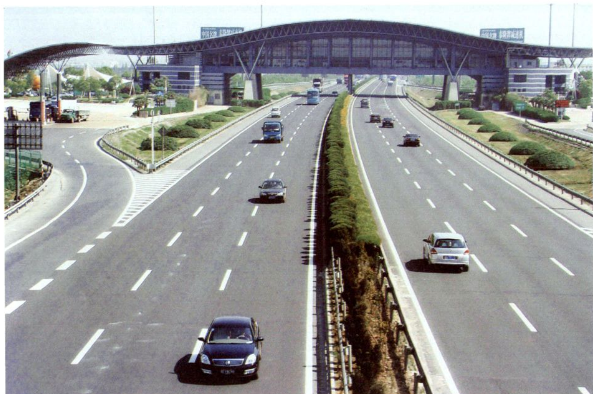
全国第一座上跨式服务区——锡澄高速公路堰桥服务区
