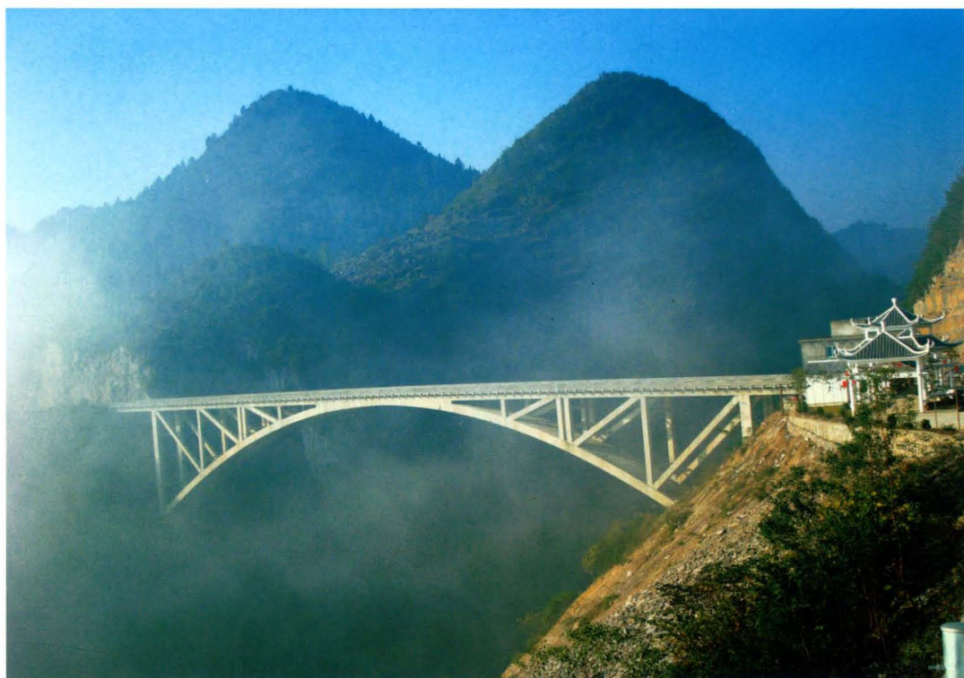
上龙灯特大桥
