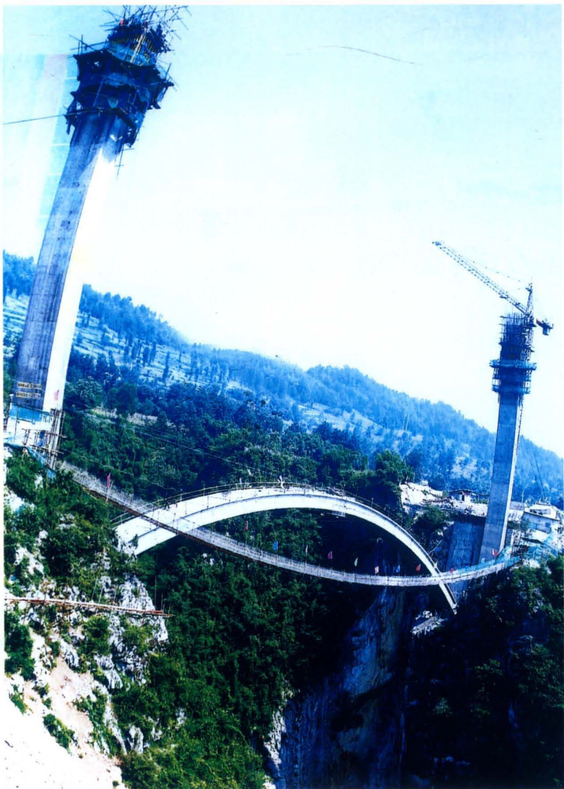
国内首例采用负 角度竖转工艺在建的 珍珠大桥
