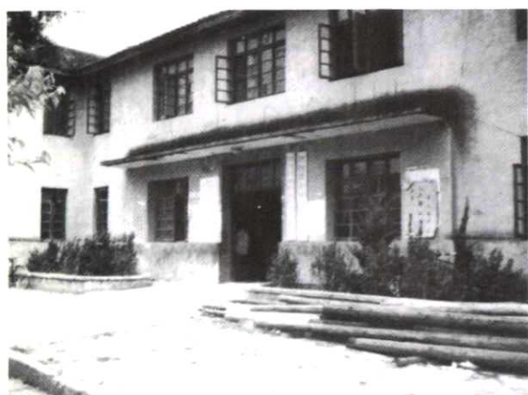
1990 年竣工的全南县邮电综合生产楼
