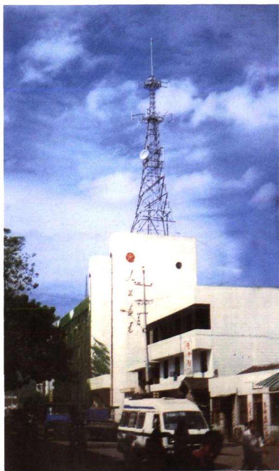
1995 年新建的全南县邮电综合生产楼
