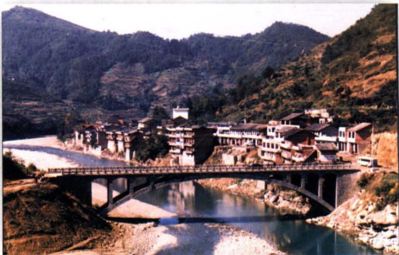
1997年兴建的赤南大桥，全长77延米，为本县20世纪末单孔跨径最大的石拱桥。
