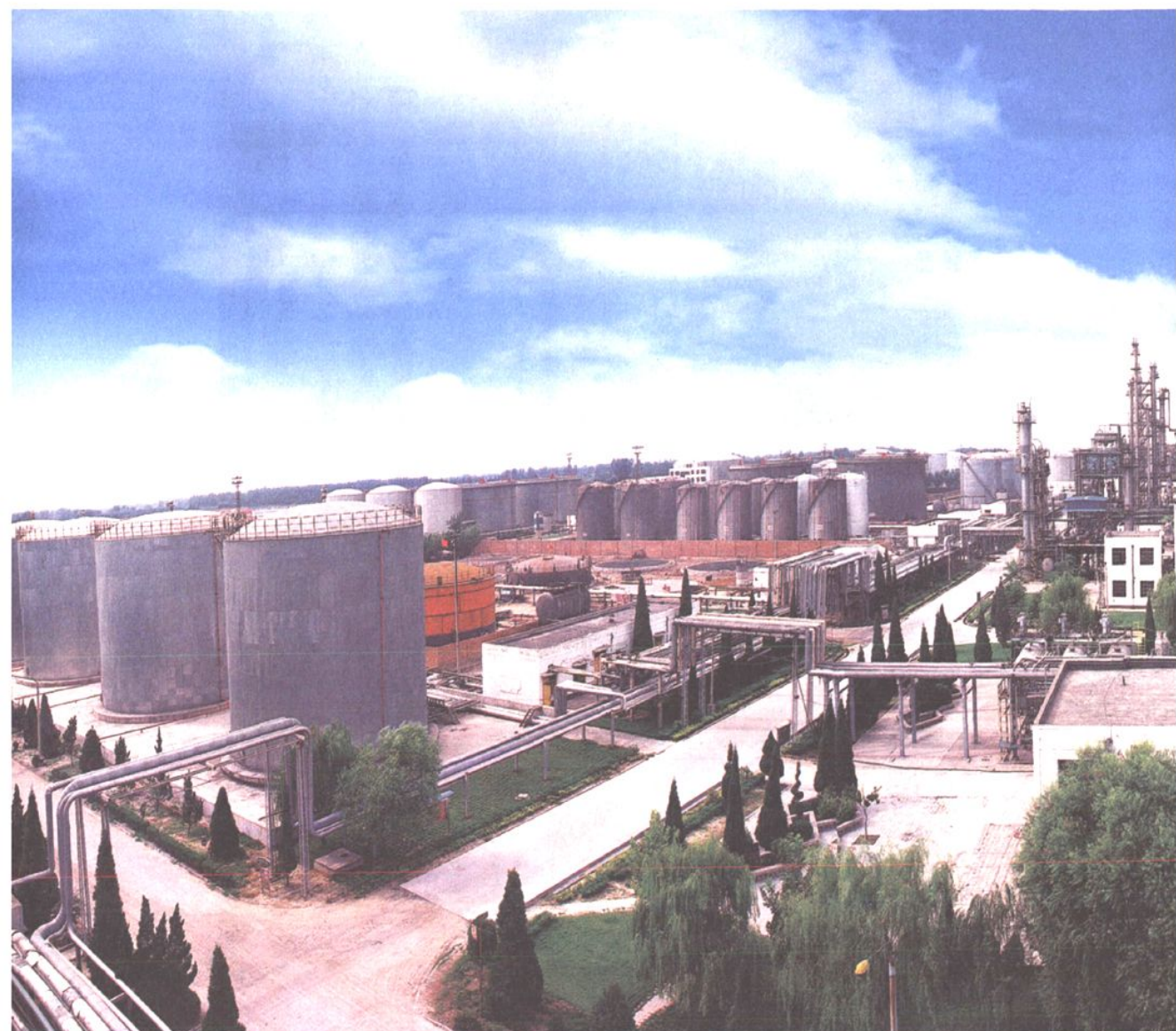
东明石化厂区
