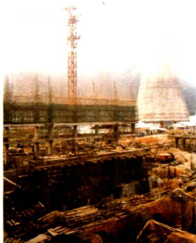
紧张施工中的二期工程
