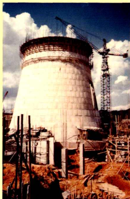
1989年6月21日，一期 工程一号冷水塔封顶
