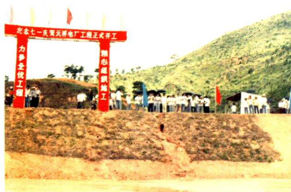
1988年7月1日，一期工程主厂区正式开工典礼
