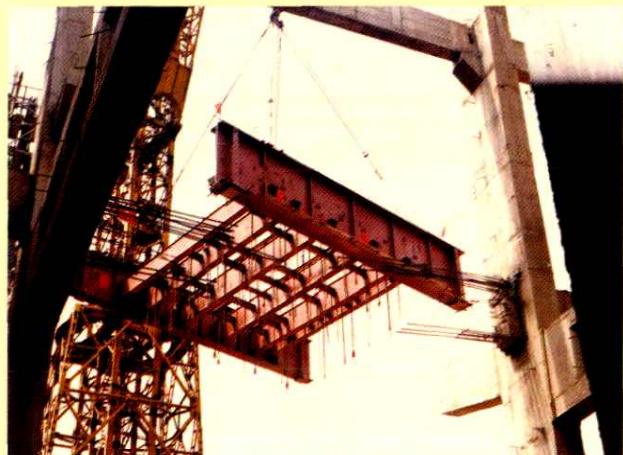
1990年4月2日，一号大炉吊装大板梁
