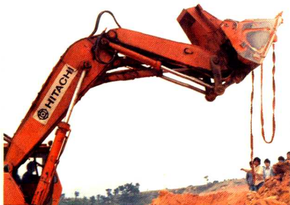
厂区正式开挖
