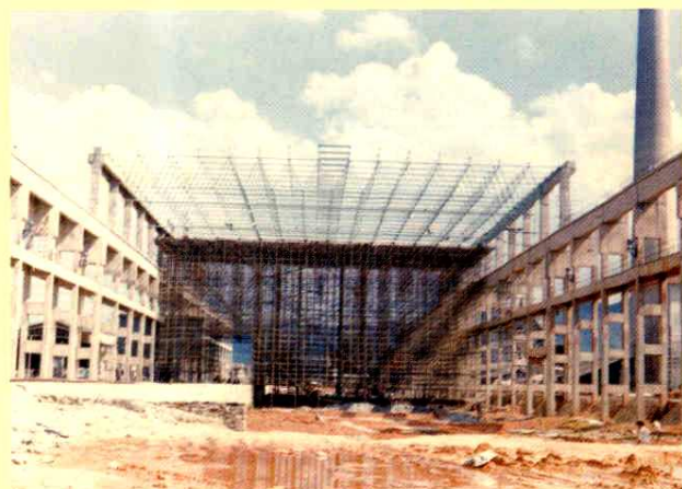
1990年4月24日，干煤棚网架安装
