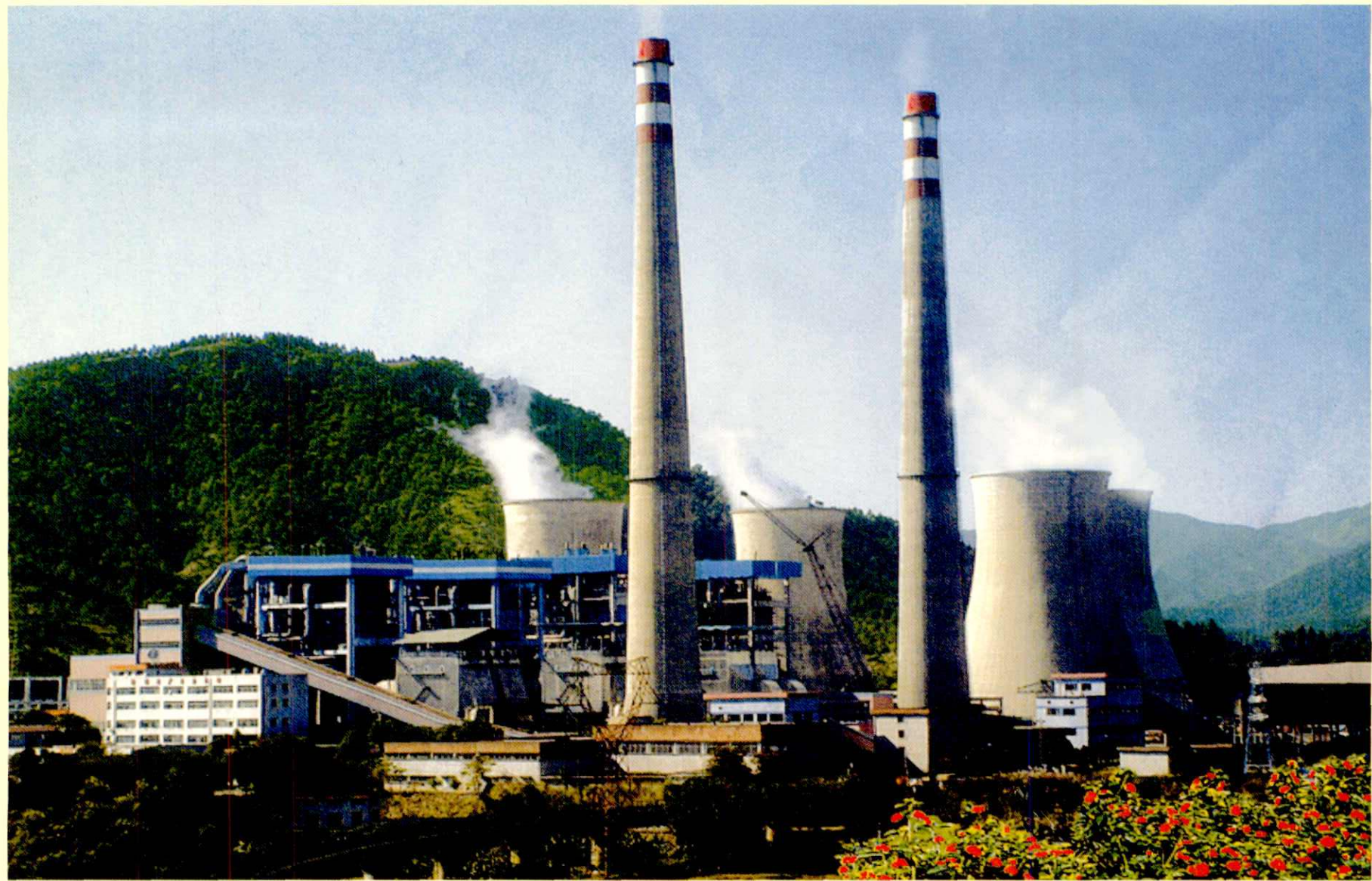
云浮发电厂全景
