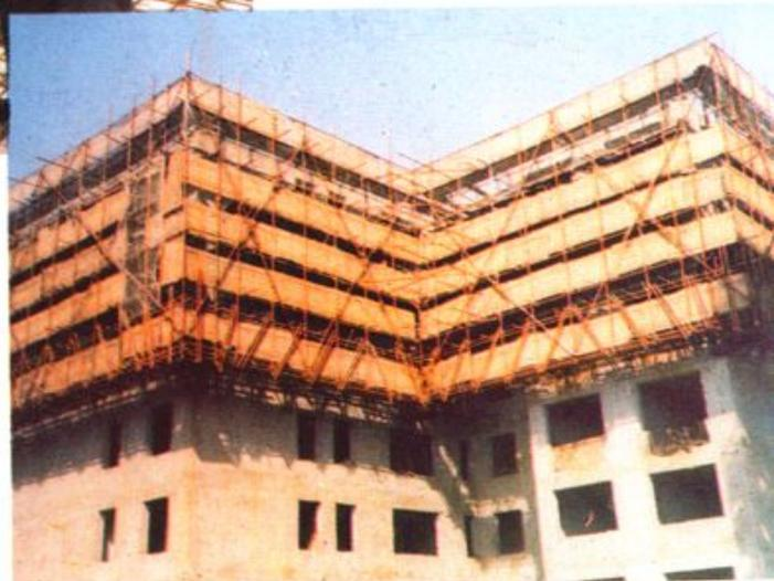
右：在施工中运用脚手架整体提升工艺
